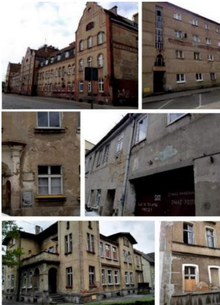
Zdjęcie 7. Budynki mieszkalne w obszarze rewitalizacji
